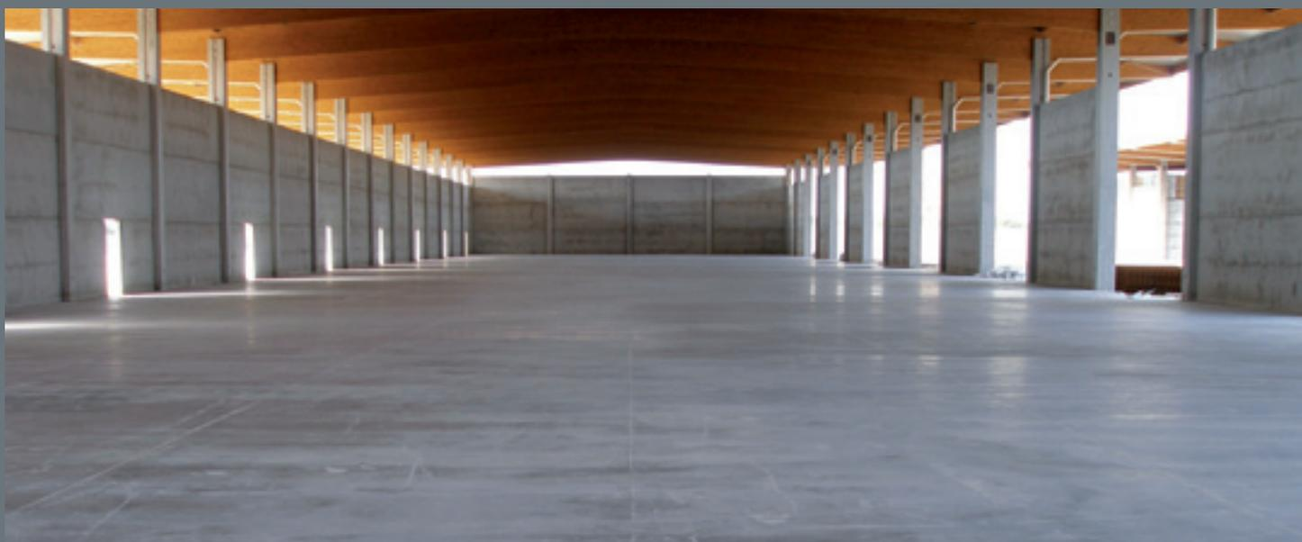
I giunti di costruzione sono soluzioni di continuità all'interno delle pavimentazioni in calcestruzzo, che separano porzioni di pavimento realizzate in periodi diversi. I giunti di costruzione non sono semplici "riprese di getto"; gli operatori sanno quanta manutenzione richiedano questi elementi, ritenuti a livello mondiale il tallone d'Achille di tutte le piastre di calcestruzzo (strade, ponti, aeroporti, piazzali e pavimenti industriali).
