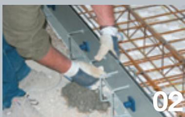
I moduli da 3 m lineari vengono assemblati con viti in PVC.
