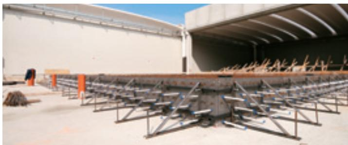
La fondazione è costituita da una piastra in calcestruzzo dello spessore di 90 cm, con un sottofondo non armato di 10 cm, una piastra di 60 cm con doppia armatura incrociata e un rivestimento cementizio da 20 cm, collegato strutturalmente alla piastra e armato con rete elettrosaldata.
