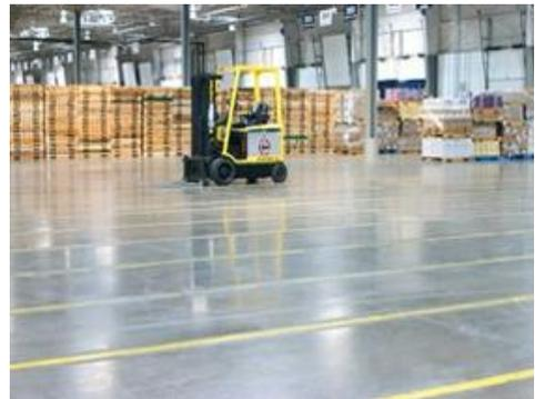
A travers un processus d'échange chimique-ionique, IDEAL HARD développe des liaisons internes qui densifie le support en le transformant en un corps unique, homogène et endurci. Après la maturation chimique le béton résiste aux abrasions et réduit les contaminations d'huile et d'eau.
