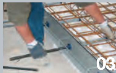
Les manches ovales sont insérés dans un raccordement en PVC.
