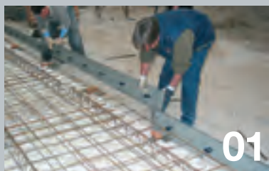
Positionnement et mise à niveau.
