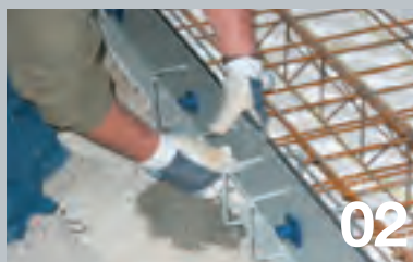
Les modules de 3 m sont assemblés avec des vis en PVC.
