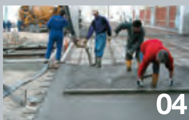
Jet de béton
