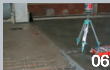
Le jour suivant on procède avec le jet de béton de l'autre côté du joint.
