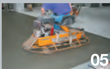
Après la pose du durcisseur on procède avec la phase de finition.
