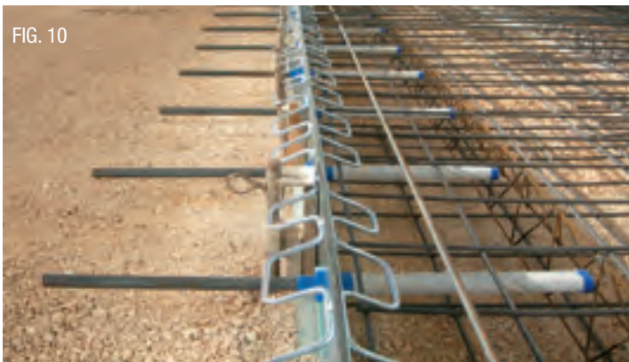
FIG. 10 Giunto di costruzione Ideal Joint System® posizionato in quota e pronto per il getto del calcestruzzo.
