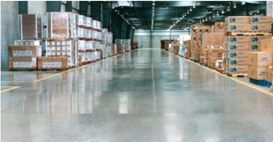
A travers un processus d'échange chimico-ionique, **Ideal Hard** développe des liaisons internes qui densifie le support en le transformant en un corps unique, homogène et endurci. Après la maturation chimique le béton résiste aux abrasions et réduit les contaminations d'huile et d'eau.
